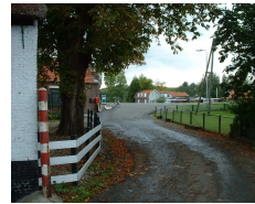
3. Bebouwing direct aan wegverharding
